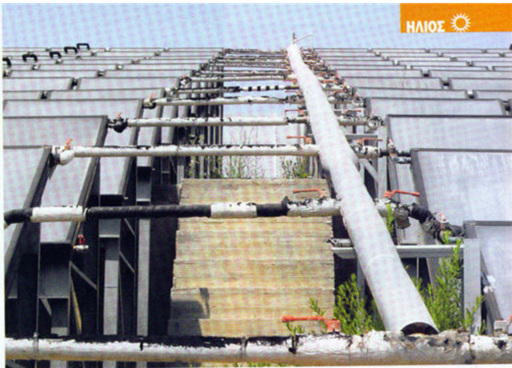
ΠΑΝΩ: Οι ηλιακοί συλλέκτες διοχετεύουν στους δύο ψύκτες ζεστό νερό θερμοκρασίας 70-75 βαθμών Κελσίου. ΚΑΤΩ: Ο κ. Λαμάρης μας μιλά για την αισιοδοξία του ενόψει του νέου αναπτυξιακού νόμου, αφού όπως τονίζει η στασιμότητα στο χώρο των ΑΠΕ στη χώρα μας -προς το παρόν- οφείλεται στην αστάθεια των προγραμμάτων επιδότησης.
